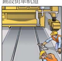
澆注混凝土軌道板
