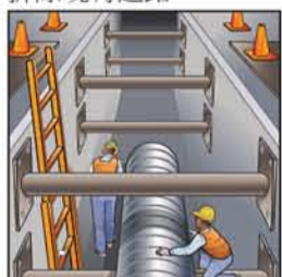
安裝地下公用設施
