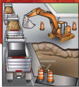
拆除現有道路
