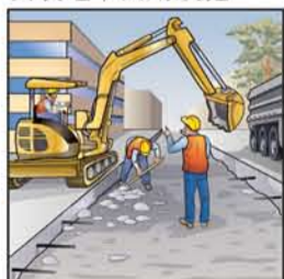
挖掘軌道路基
